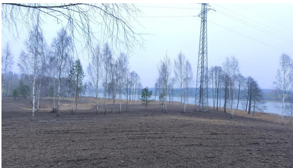
Fot.5. Sieć elektroenergetyczna WN 110kV
